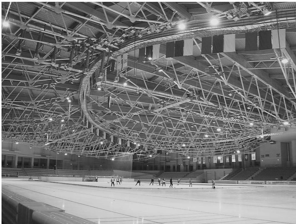
Рис. 7. Ледовая арена конькобежного центра в Крылатском.
